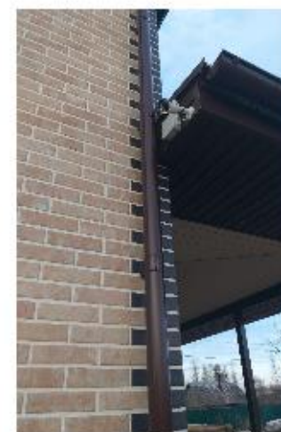
Видеонаблюдение на даче 4 АHD камеры с разрешением 2МП
