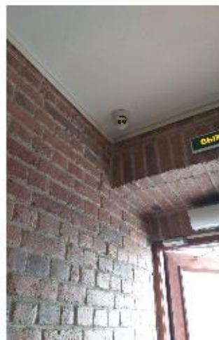
Видеонаблюдение в ресторане 7 IP камер с разрешением 2МП (+запись звука)
