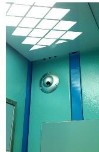
Видеонаблюдение в подьезде 4 IP камеры с разрешением 2МП
