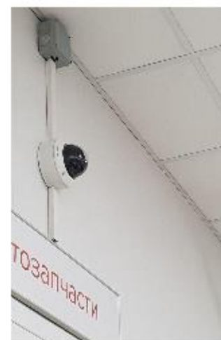
Видеонаблюдение в автосервисе 4 IP камеры с разрешением 2МП (+запись звука)
