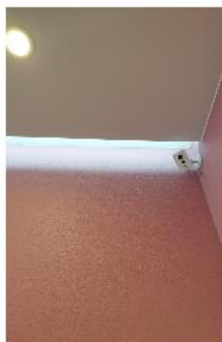
Видеонаблюдение в квартире 2 IP камеры с разрешением 1.3МП с Wi-Fi (+запись звука)
